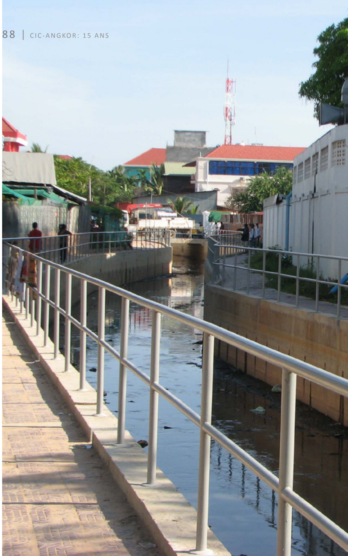
Canalisation des eaux usées - Ville de Siem Reap
