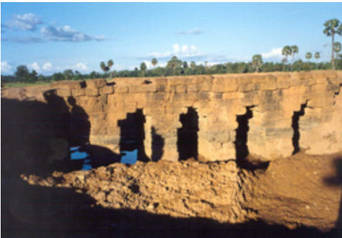
Pont ancien - Kompong Kdei
