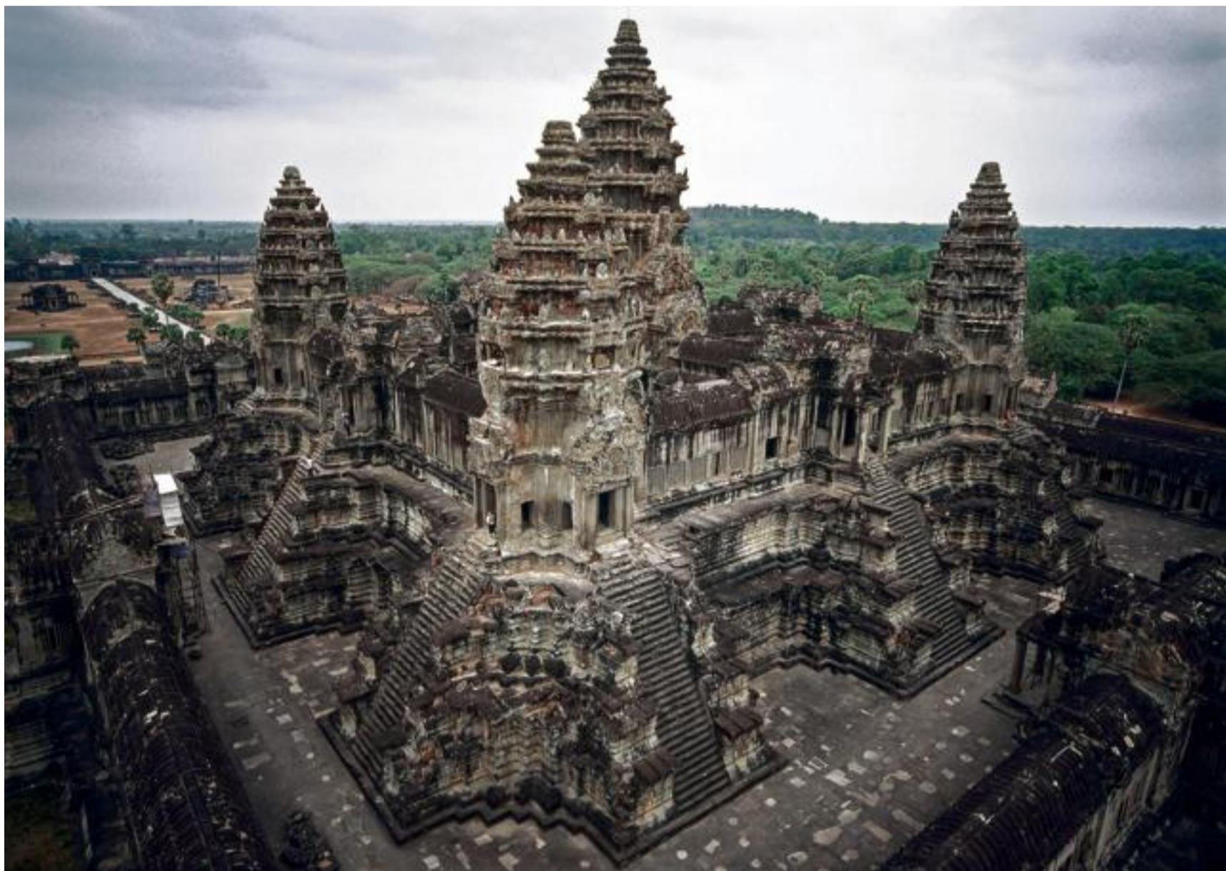
Vue de la terrasse supérieure des cinq tours d'Angkor Vat, dont les décors ciselés dans le grès se dégradent. PHILIPPE LAFOND
